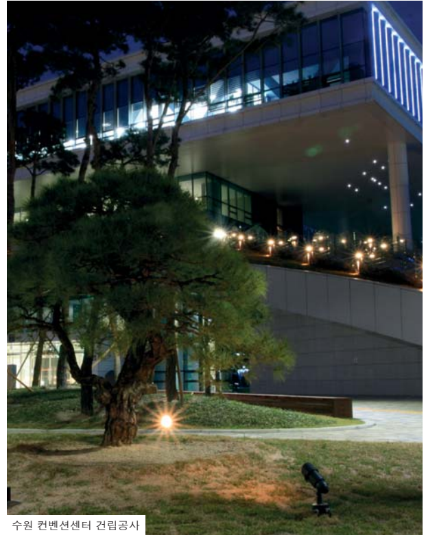
수원 컨벤션센터 건립공사
